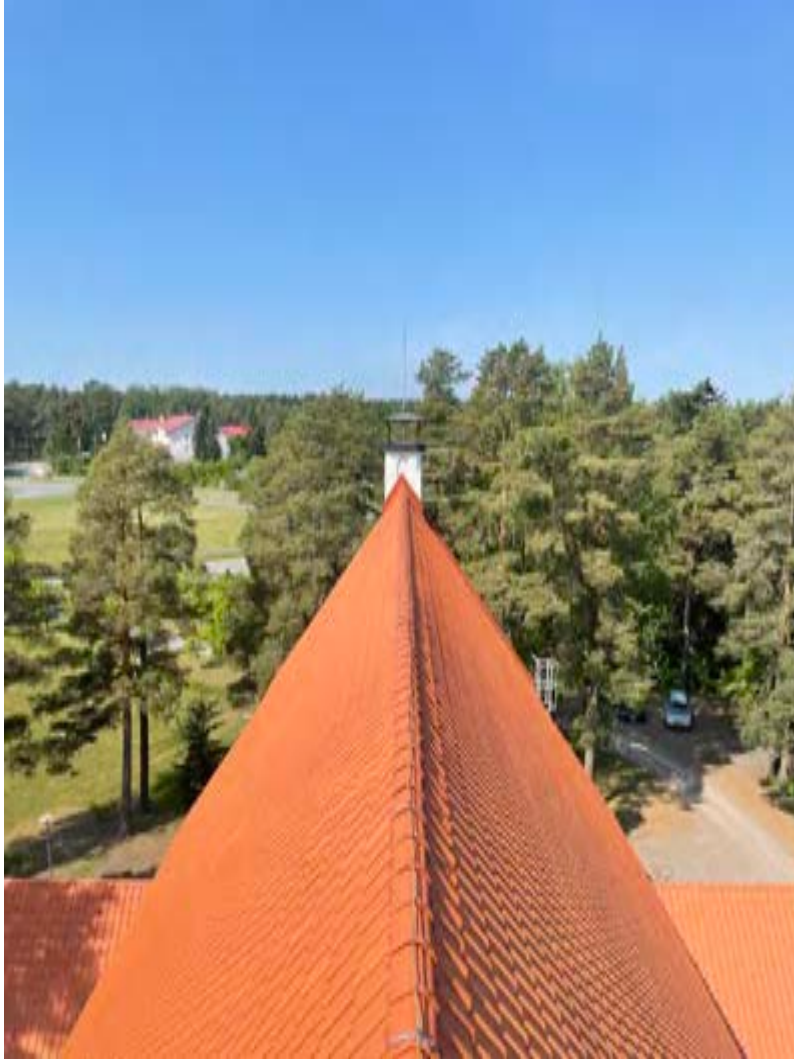
Kirkon kattotiilet ovat malliltaan Rubin 13 V savitiilenpunaisia tiiliä
