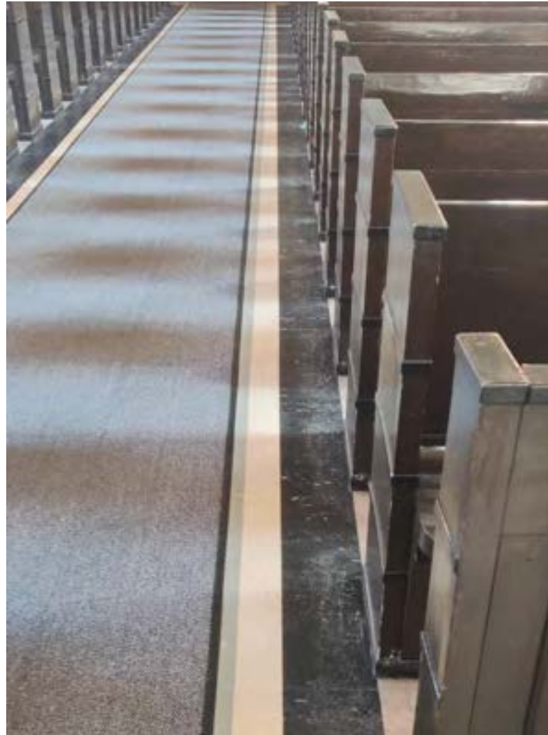
Kirkkosalin penkkien alla on linoleumimatto ja kirkkosalin käytävällä on alkuperäiset kumilaatat
