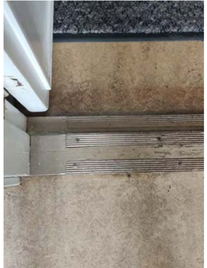
Sakastiin sekä sen eteis- ja wc-tilaan asennettiin linoleumimatto
