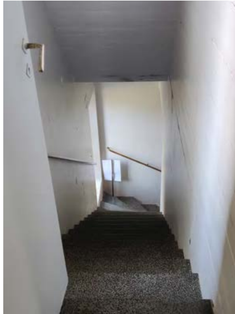
Urkuleterille johtava mosaiikkibetoniporras ja vuonna 1985 lisätyt messinkiprofilista tehdyt käsijohteet
