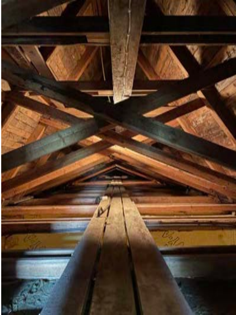
Kirkon ullakolle tehtiin kirkkosalin suuntainen ja mittainen kulkusilta puusta
