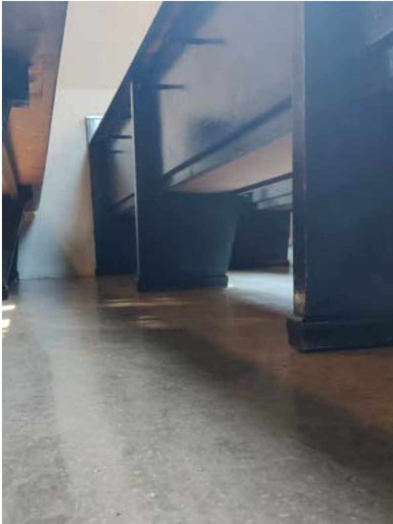
Olemassa olevien massalattioiden päälle asennettiin lattiakaavioiden mukainen linoleumimatto. Kirkkopenkkeiden alle asennettiin akustiset pehmusteet.
