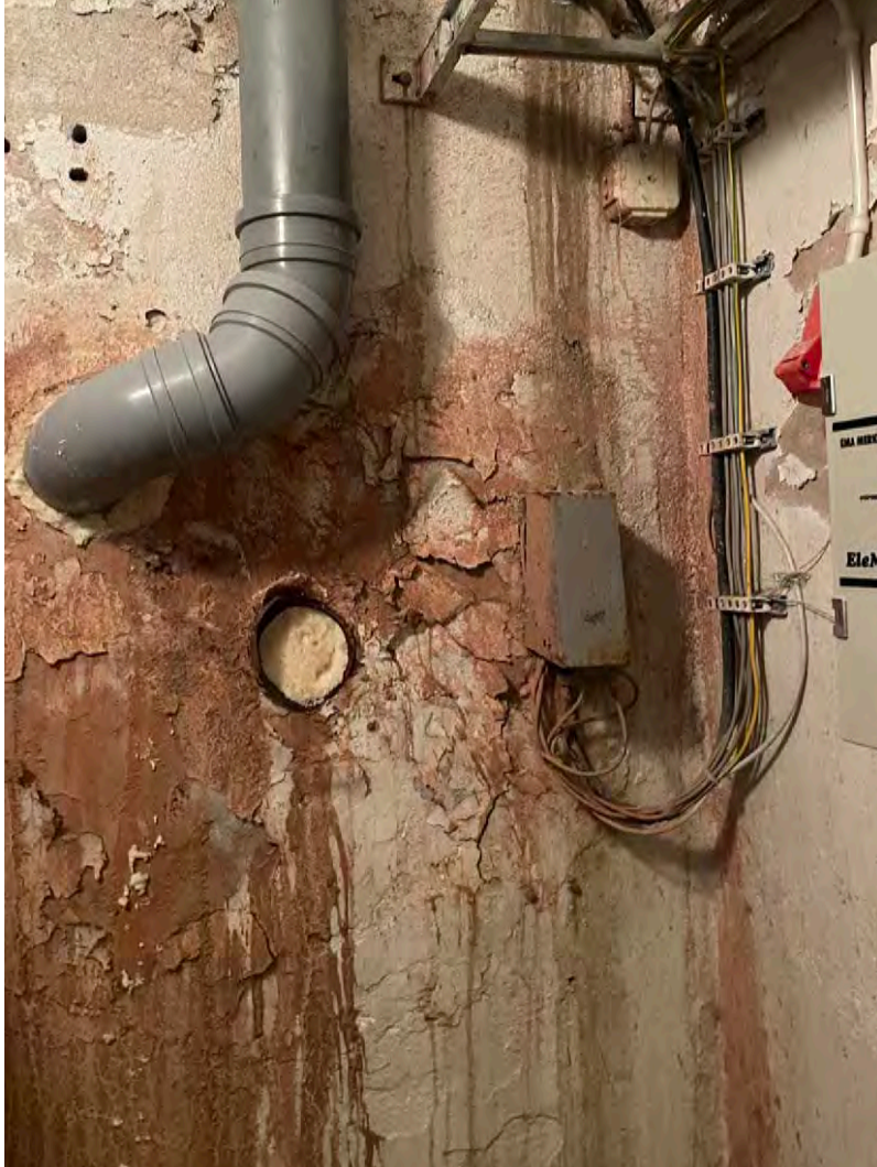
Sähköpääkeskuksen seinä ja tulpattu vanha viemäriäpivienti
