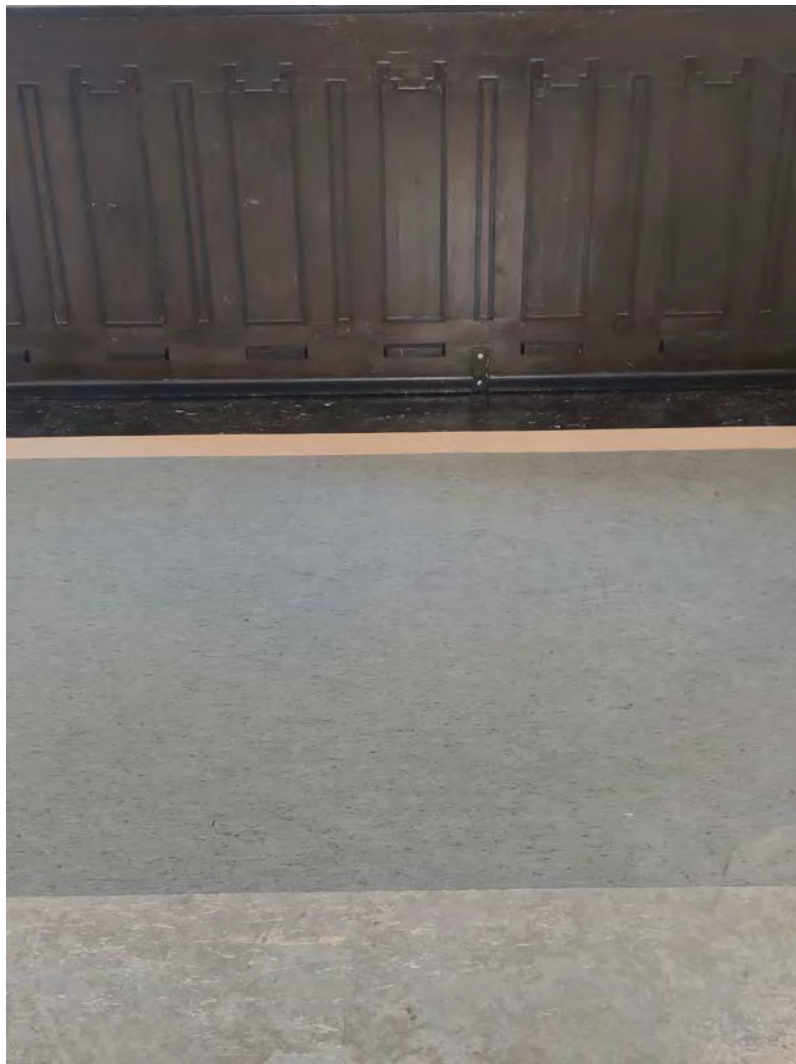
Kirkkosalin poistettujen penkkirivien kohdalle on kumilaatan sijaan lisätty myöhemmässä vaiheessa kiiltäväpintainen muovimattokaistale
