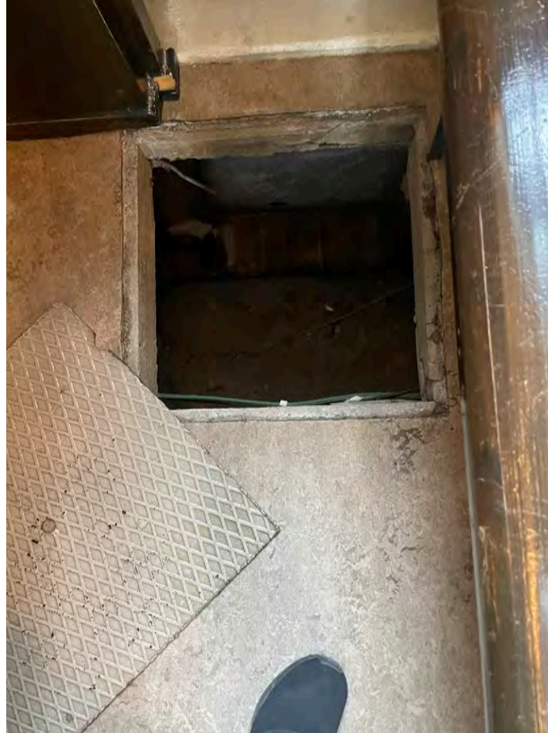
Toinen kirkkosalin lattiassa sijaitsevista ja huoltotunneleihin johtavista lattialuukuista
