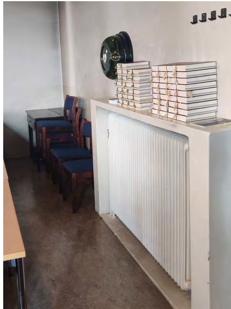
Kirkkosalin pääsisäänkäynnin yhteydessä olevat ulkonevat betoniset patterikotelot
