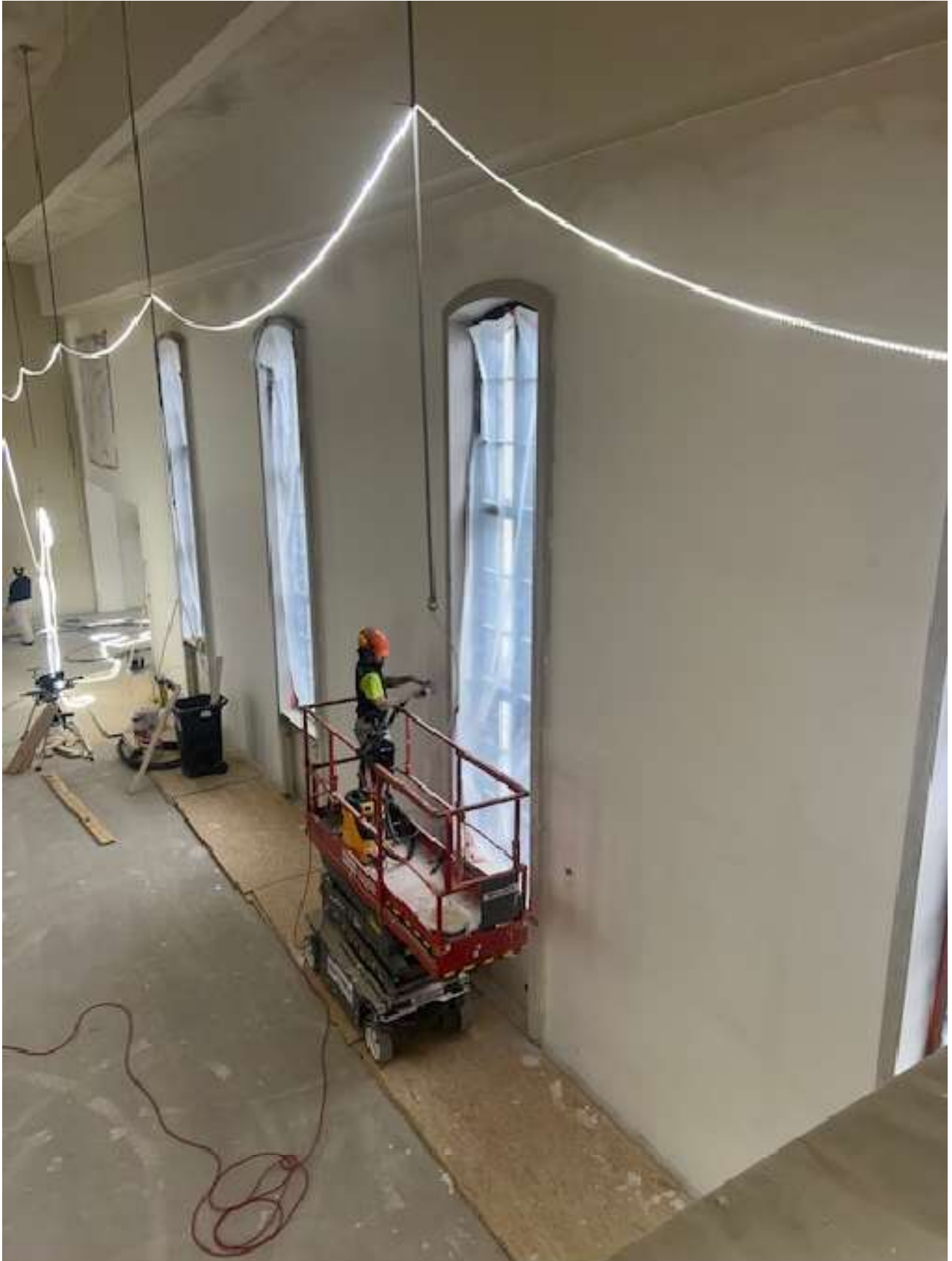
Kirkkosalin seinien viimeistely käynnissä.
