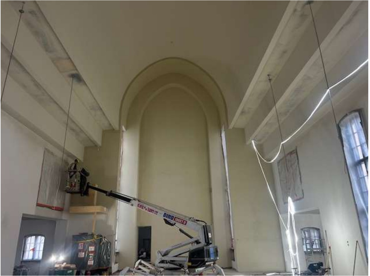
Kirkkosalin katto maalattu ja alttariseinän maalaus käynnissä
