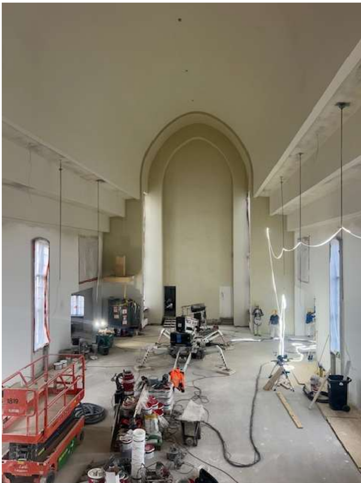
Kirkkosalin katto maalattu ja alttariseinän maalaus käynnissä
