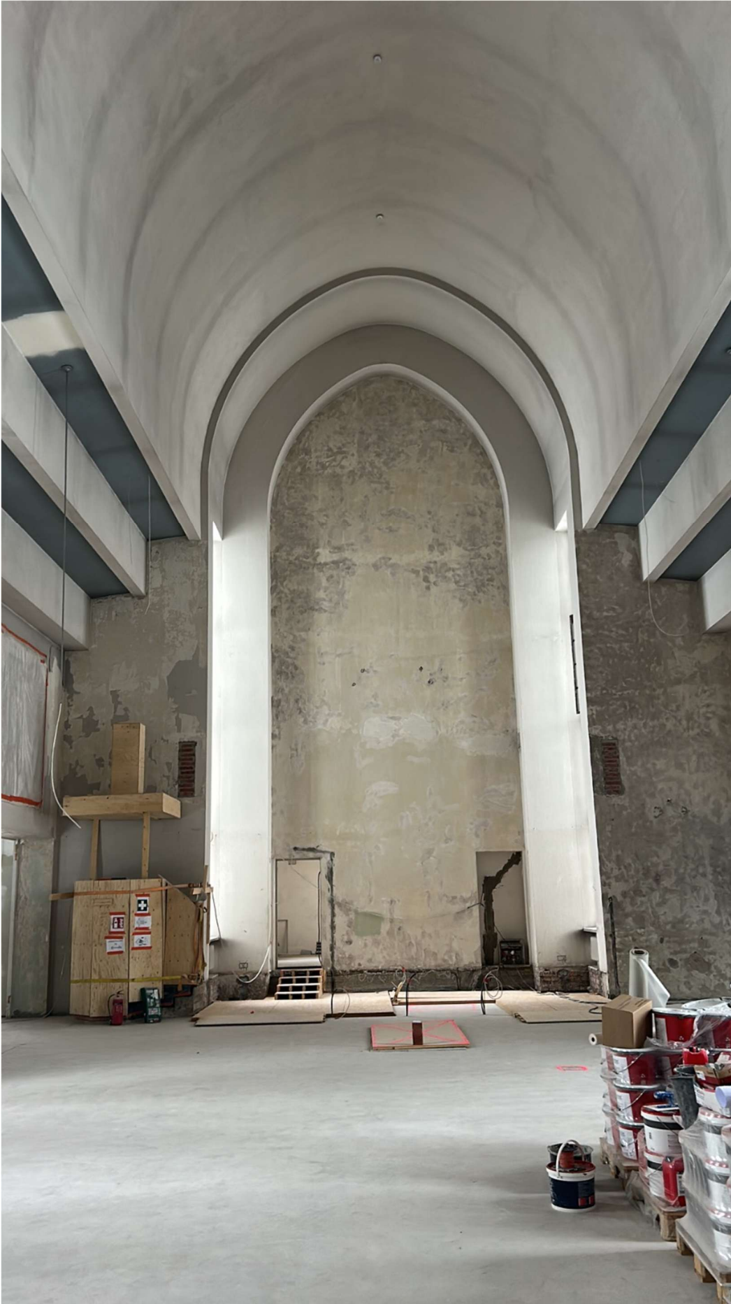
Koski Tl Kirkko Kosken kirkon sisäpuolen peruskorjaus
