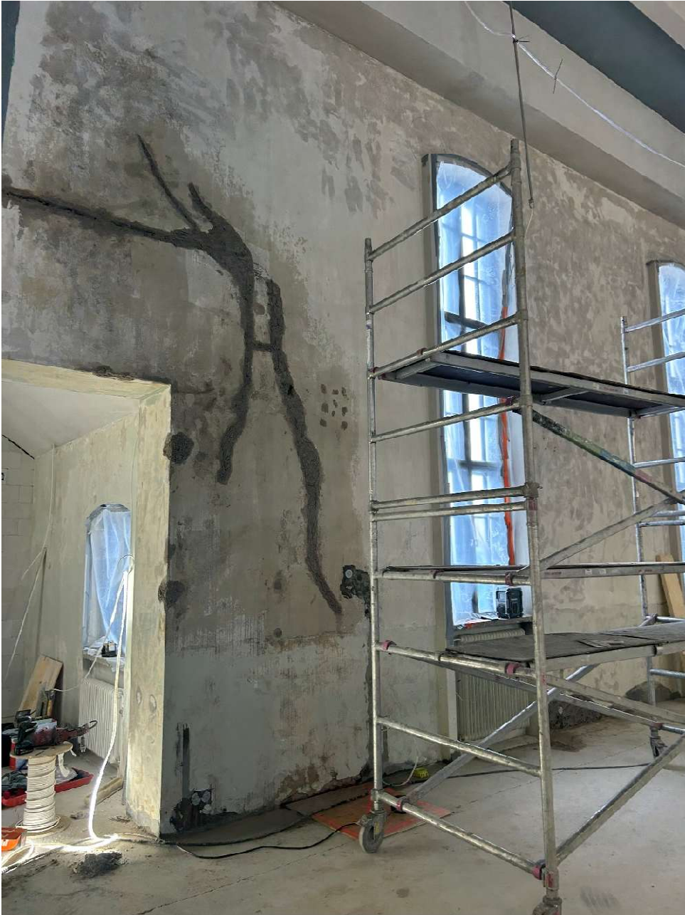
Ulkoseinien paikkaukset käynnissä
