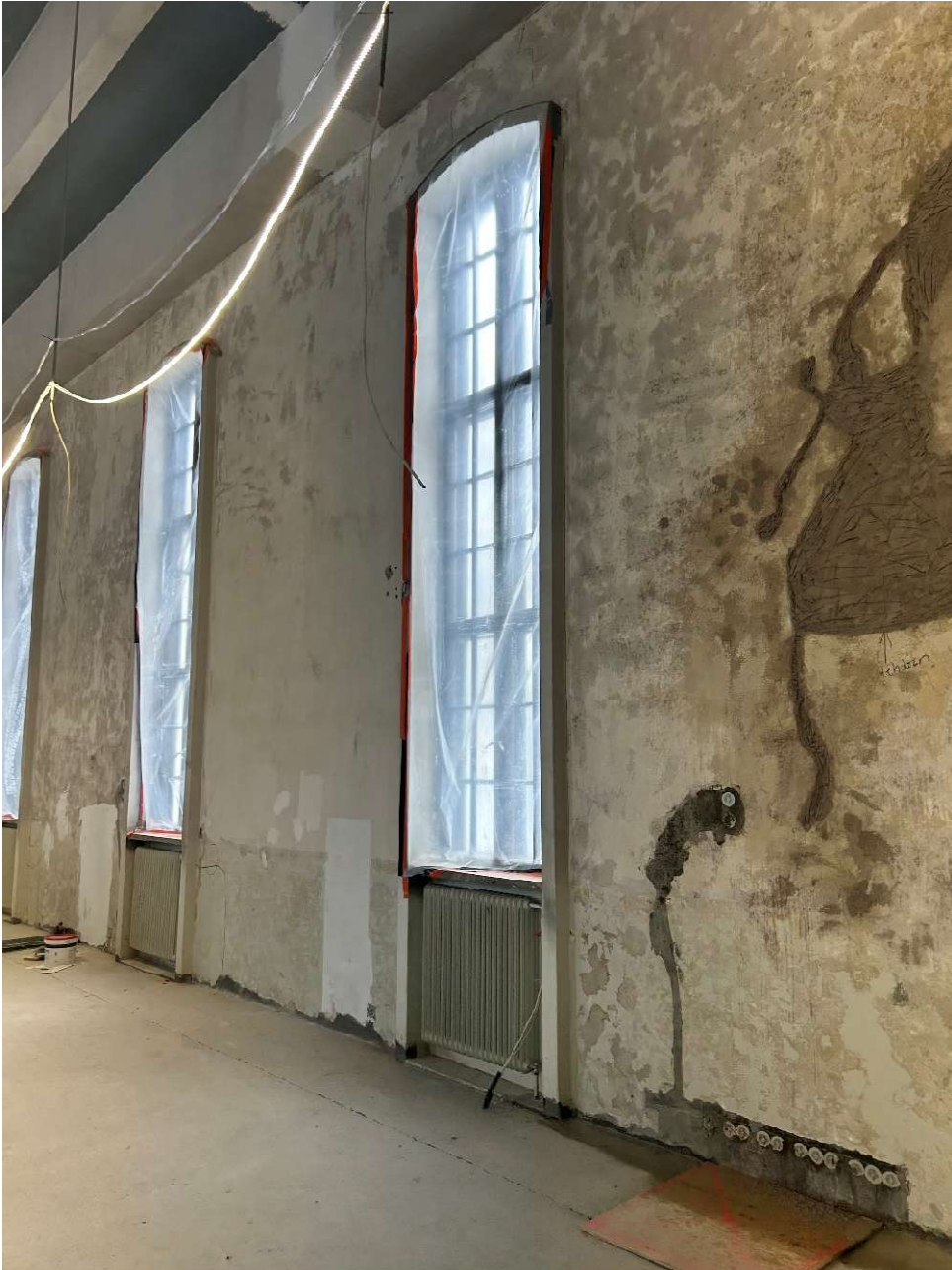
Ulkoseinien paikkaukset käynnissä ja mallit taustalla
